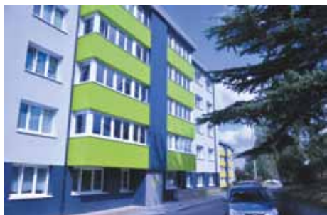
Rue des Sarts 46 à Couillet
