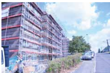
Rue des Sarts 48 et rue des Peupliers 2 à Couillet
