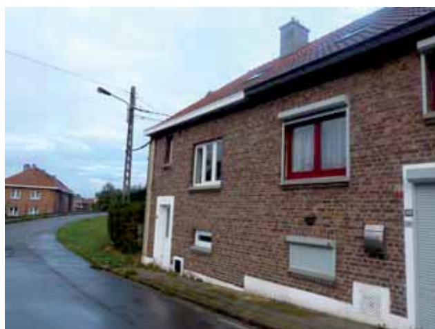
Rue Corniche 88 – Couillet
