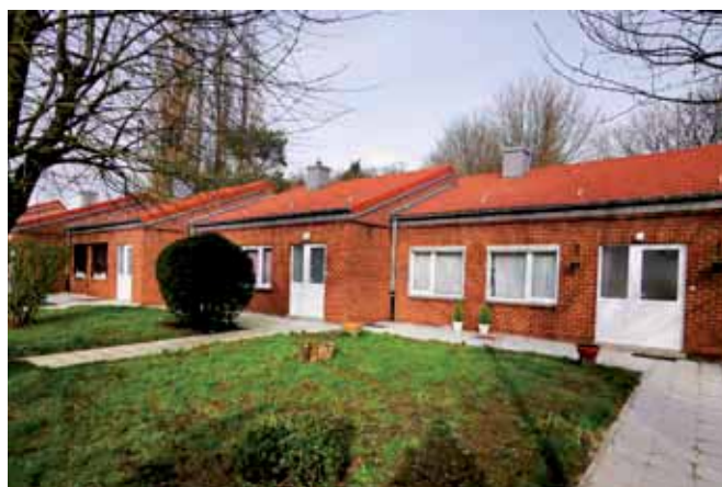
Rénovations rue Belle Vue à Jumet
