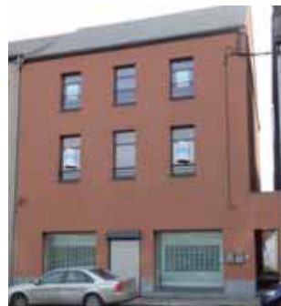
LOYER 606€ Route de Mons, 16/021 MARCHIENNE-AU-PONT 3 chambres
